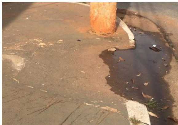
Figura 18 – Rampa de acesso R5
