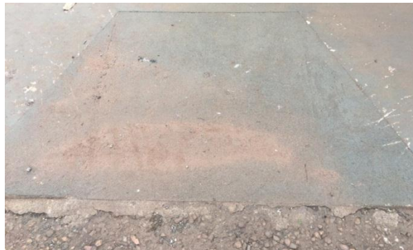
Figura 17 – Rampa de acesso R4
