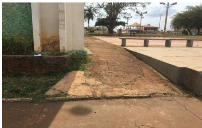
Figura 24 – Rampa de acesso R11
