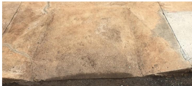
Figura 14 – Rampa de acesso R1
