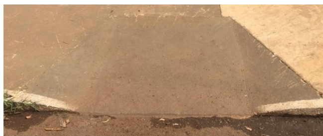
Figura 15 – Rampa de acesso R2
