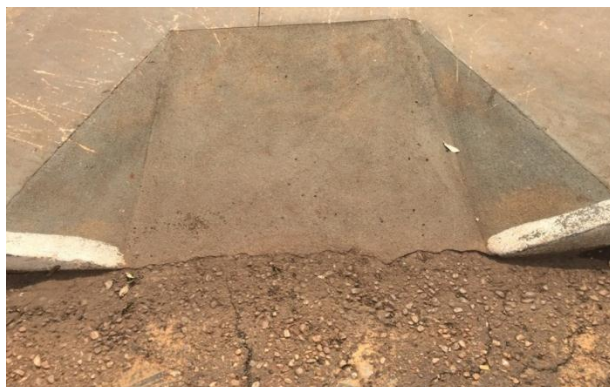
Figura 16 – Rampa de acesso R3
