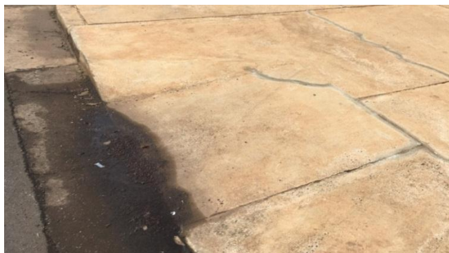
Figura 21 – Rampa de acesso R8
