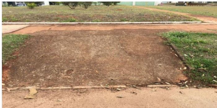
Figura 22 – Rampa de acesso R9
