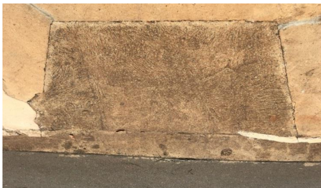
Figura 20 – Rampa de acesso R7
