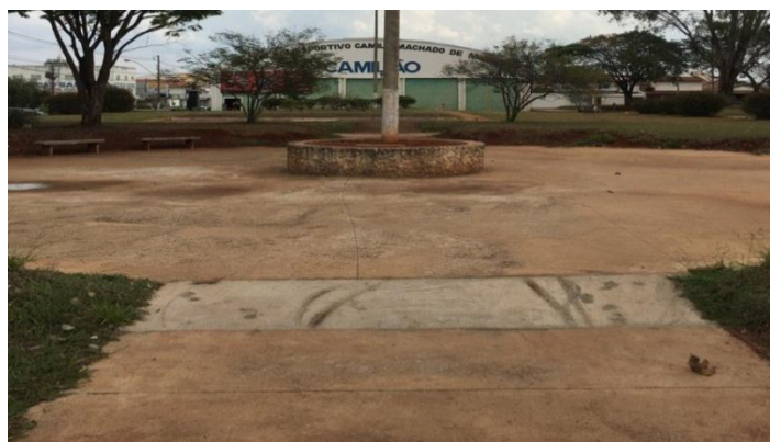
Figura 23 – Rampa de acesso R10
