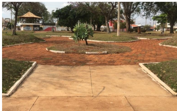
Figura 26 – Rampa de acesso R13
