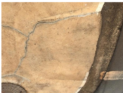
Figura 19 – Rampa de acesso R6
