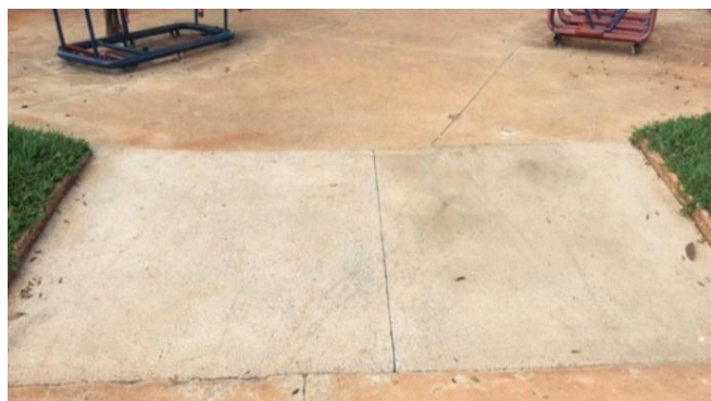
Figura 25 – Rampa de acesso R12
