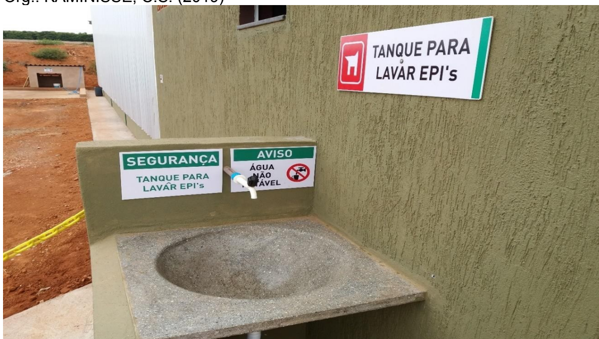
Figura 06: Tanque para lavar EPI. Org.: KAMINISSE, C.S. (2019)
