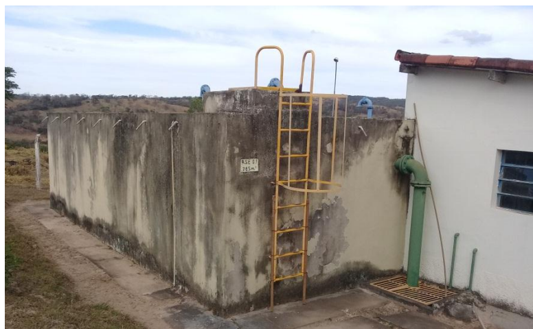
Figura 10 – Reservatório apoiado localizado na ETA
