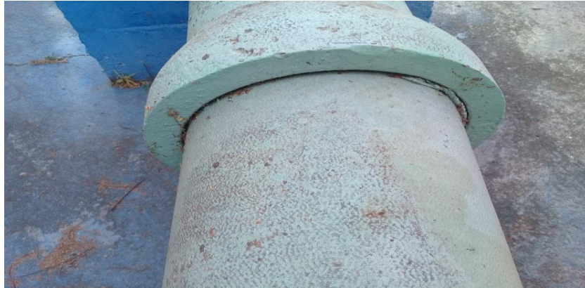
Figura 4 – Adutora de água bruta
