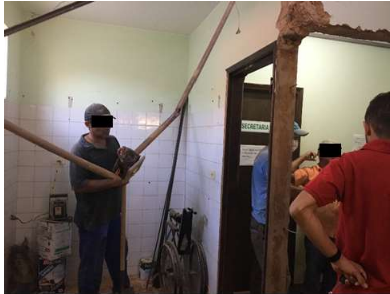
Figura 9 – Trabalhadores na ampliação de uma sala do posto da cidade
