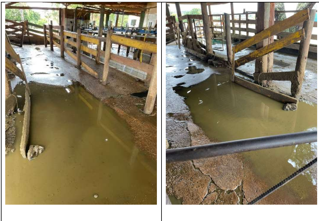
Figura 1. Escoamento inadequado.
