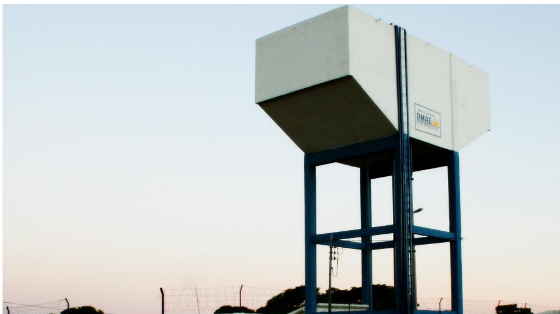
Figura 5 – Reservatório Elevado da Catulina.
