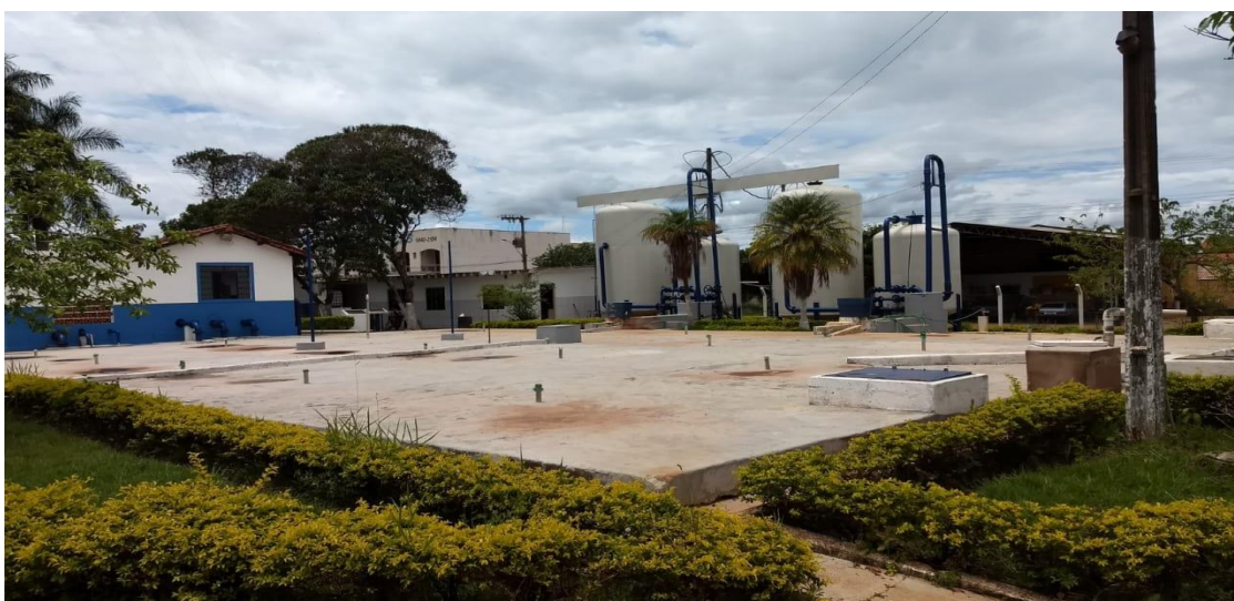
Figura 4 – Estação de Tratamento de Água de Monte Carmelo.
