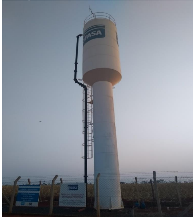
Figura 8 - Reservatório elevado de 50 m 3 .
