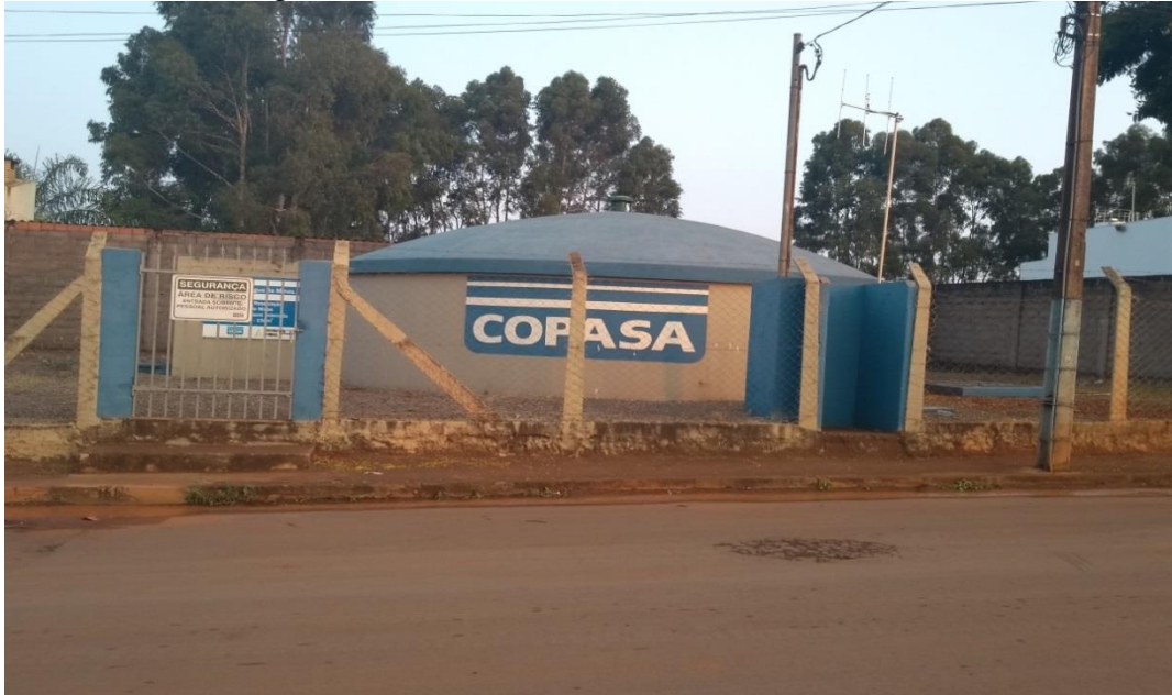
Figura 6 - Reservatório semienterrado de 150 m 3 .
