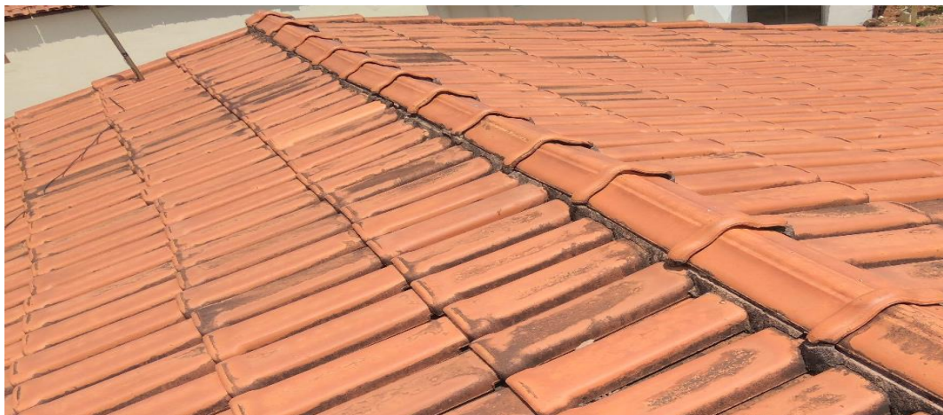
Figura 24 - Desprendimento da argamassa do emboço.
