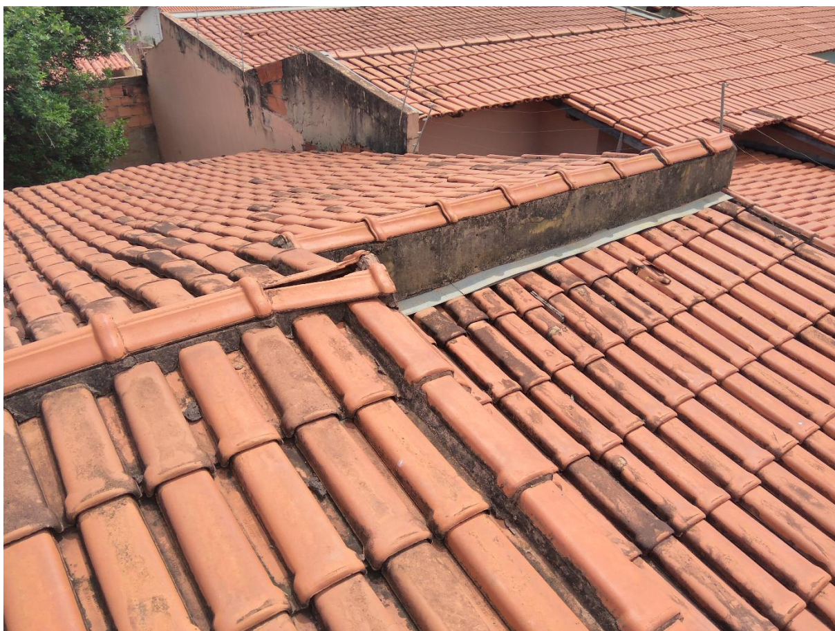
Figura 35 - Estado de conservação dessa parede.
