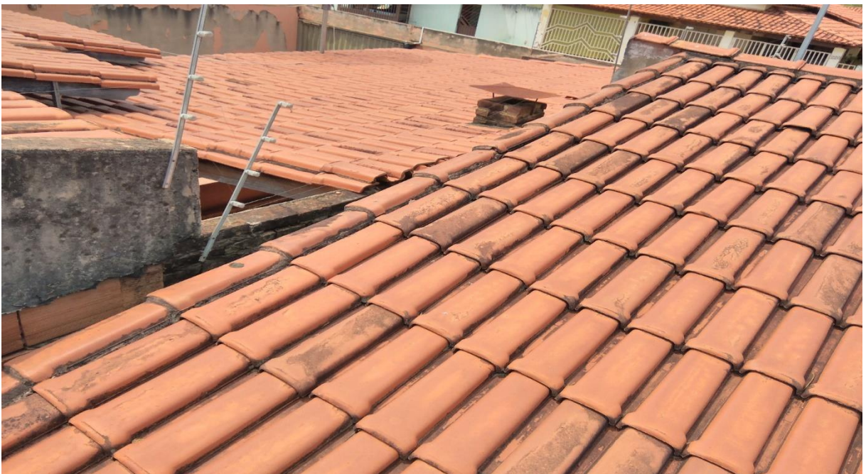
Figura 16 - Cerca elétrica na divisa com o vizinho.
