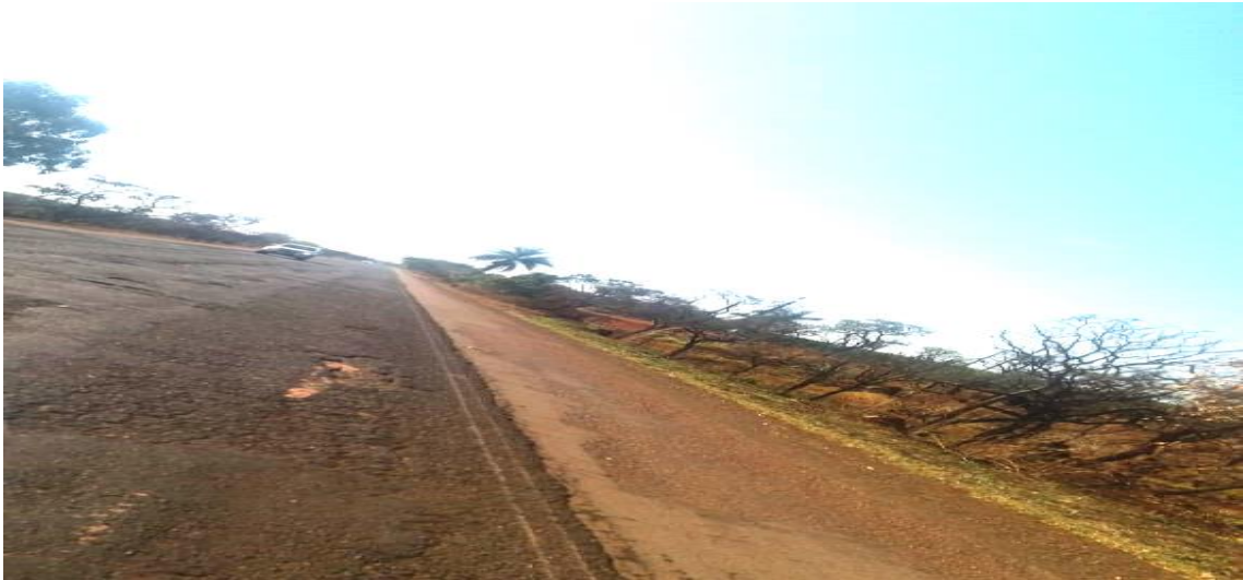
Figura 13 – Trecho com buraco, ondulações, remendos e acostamento inadequado
