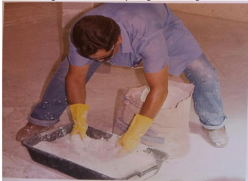
Figura 11 - Mistura do pó de gesso com a água
