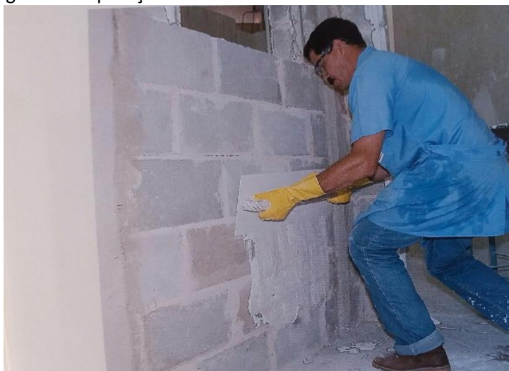
Figura 16 - Aplicação do revestimento em movimentos cruzados
