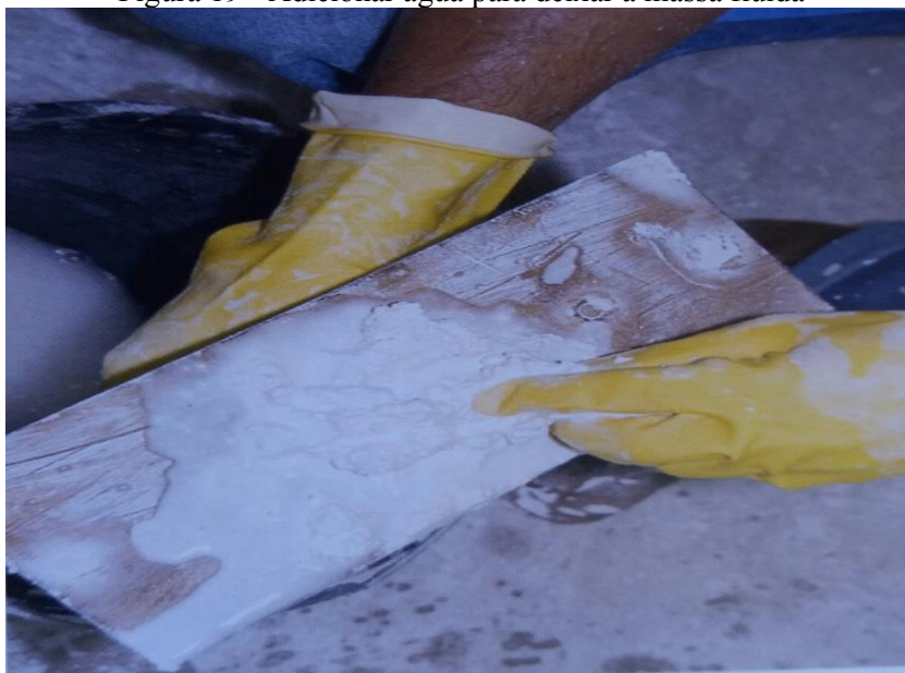
Figura 19 - Adicionar água para deixar a massa fluída
