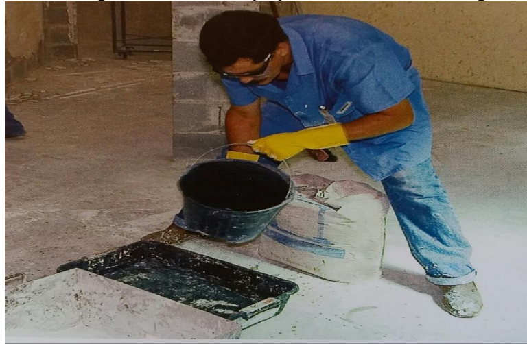
Figura 10 - Início do preparo do revestimento de gesso
