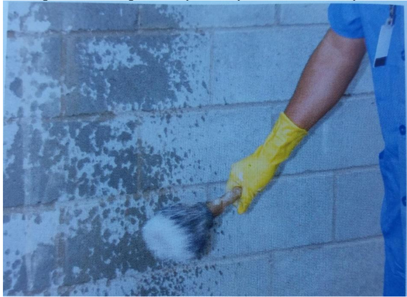
Figura 6 - Molhagem da superfície que irá receber o chapisco
