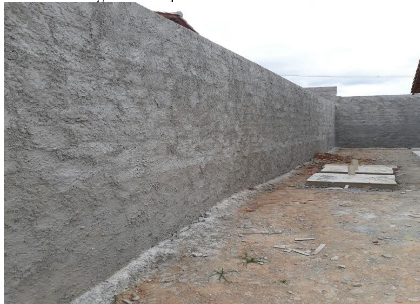
Figura 7 - Chapisco finalizado em um muro
