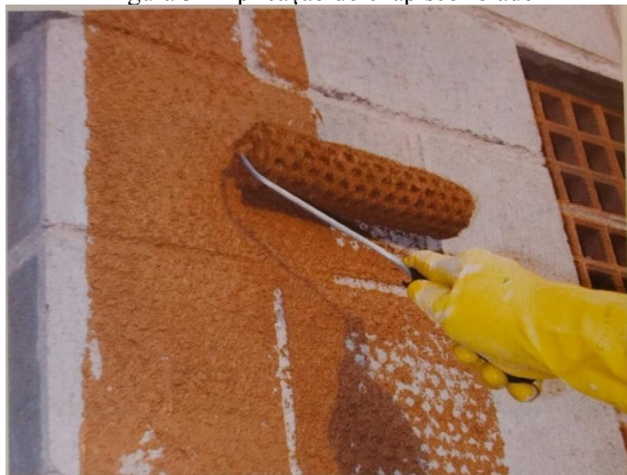
Figura 3 - Aplicação do chapisco rolado
