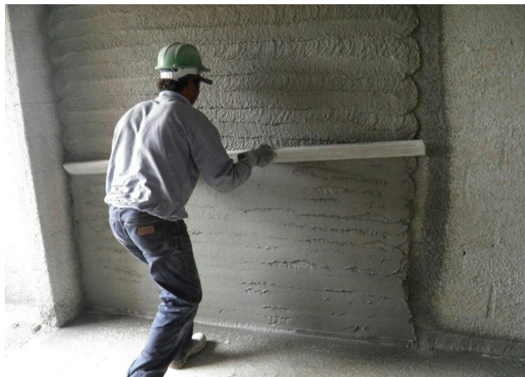
Figura 8 - Execução da camada de emboço
