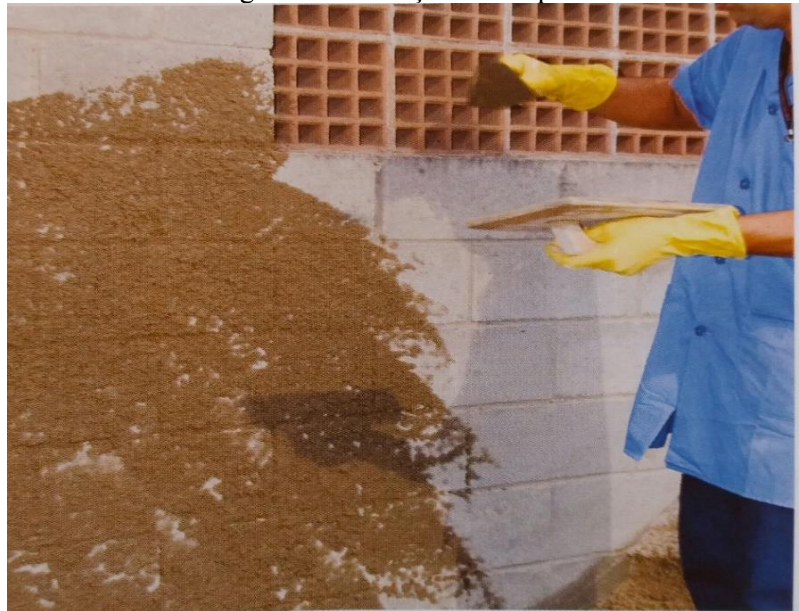
Figura 2 - Execução do chapisco
