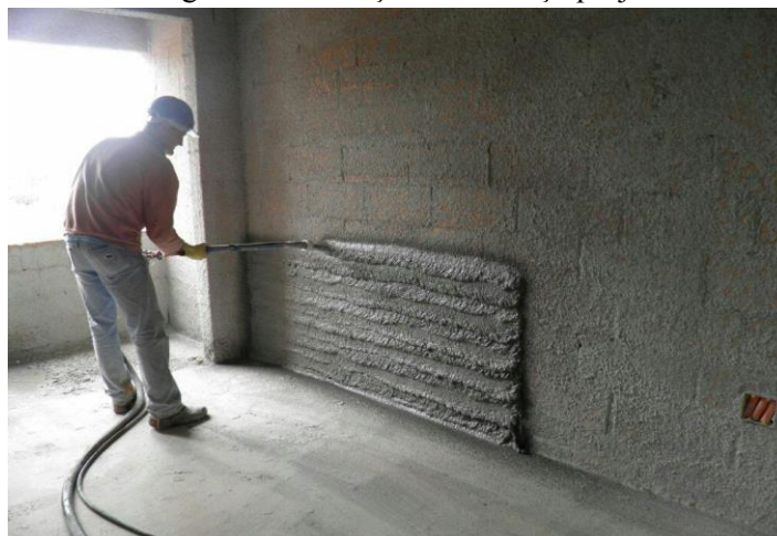
Figura 9 - Execução do emboço projetado
