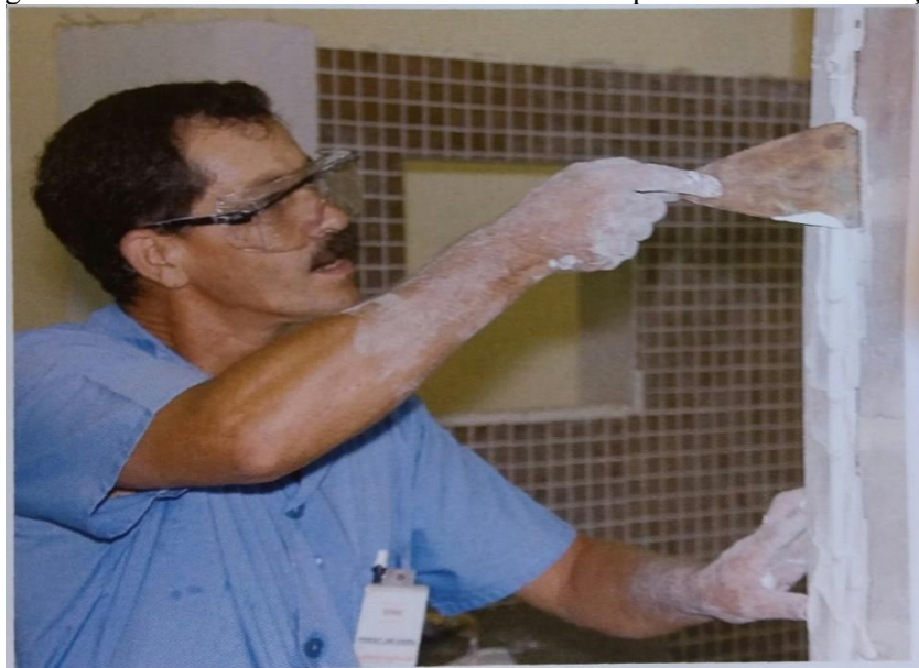
Figura 15 - Preenchimento dos vãos da cantoneira para uma melhor fixação
