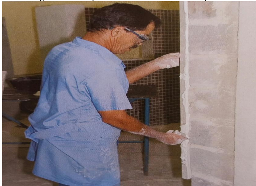
Figura 13 - Fixação da cantoneira no vértice da parede
