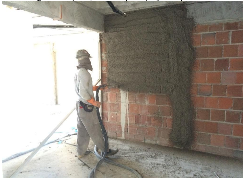
Figura 4 - Aplicação do chapisco projetado por bomba
