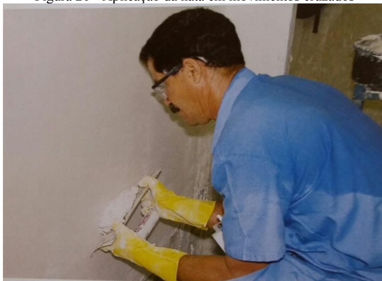
Figura 20 - Aplicação da nata em movimentos cruzados
