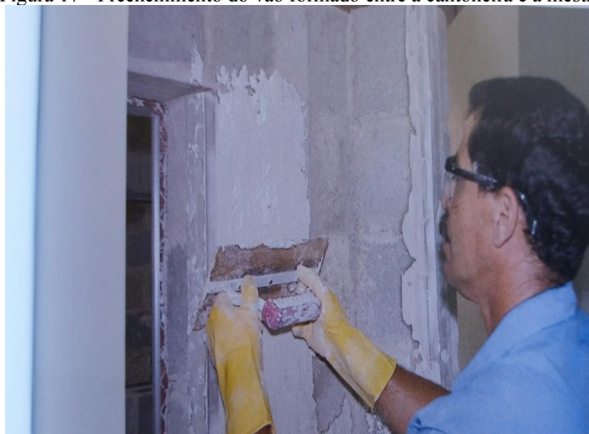
Figura 17 - Preenchimento do vão formado entre a cantoneira e a mestra
