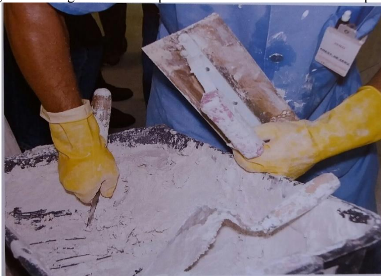
Figura 18 - Argamassa a ser aproveitada no acabamento final da parede
