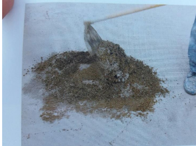
Figura 5 - Preparo do chapisco feito com cimento e areia
