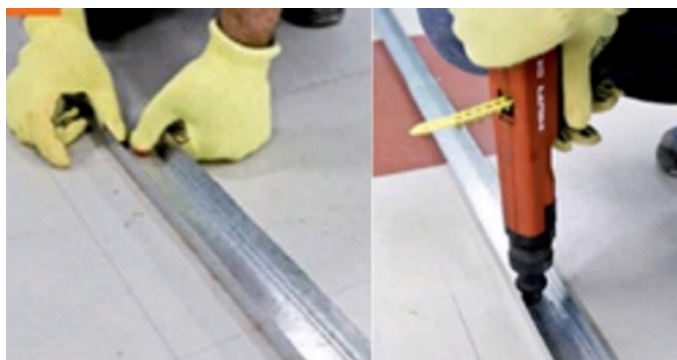
Figura 2 - Instalação das guias
