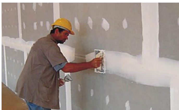
Figura 9 - Acabamento das placas de gesso
