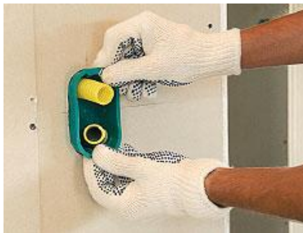
Figura 5 - Instalação de caixas elétricas
