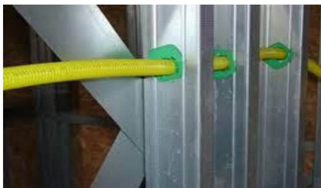
Figura 6 - Instalação de eletrodutos
