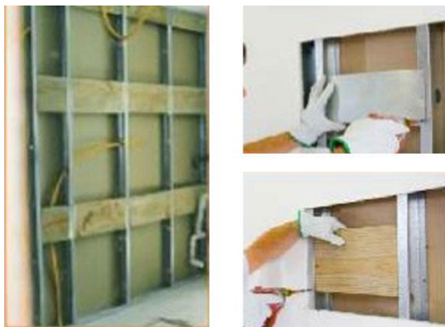
Figura 8 - Fixação dos reforços
