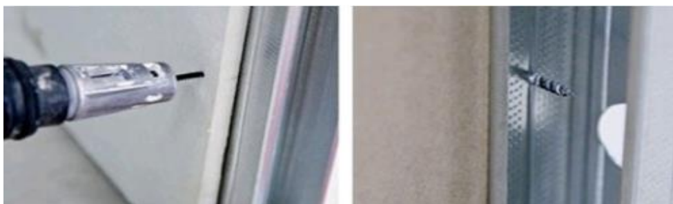
Figura 4 - Instalações das chapas de Drywall
