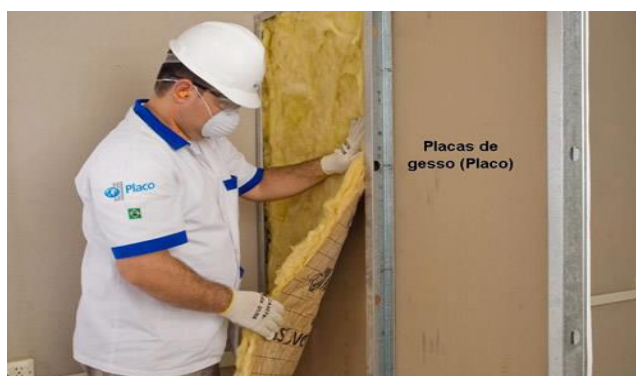
Figura 7 - Instalação de isolamento acústico
