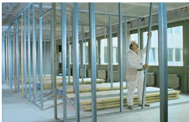
Figura 3 - Instalação dos montantes
