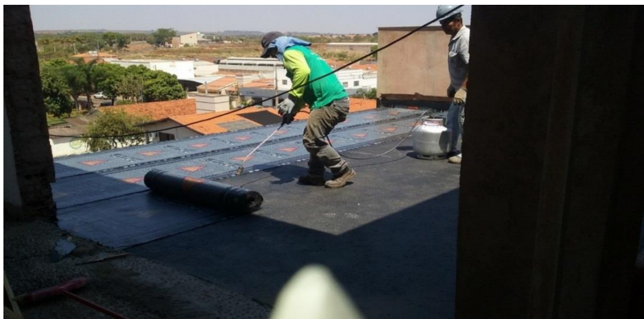
Figura 5 - Execução da manta asfáltica
