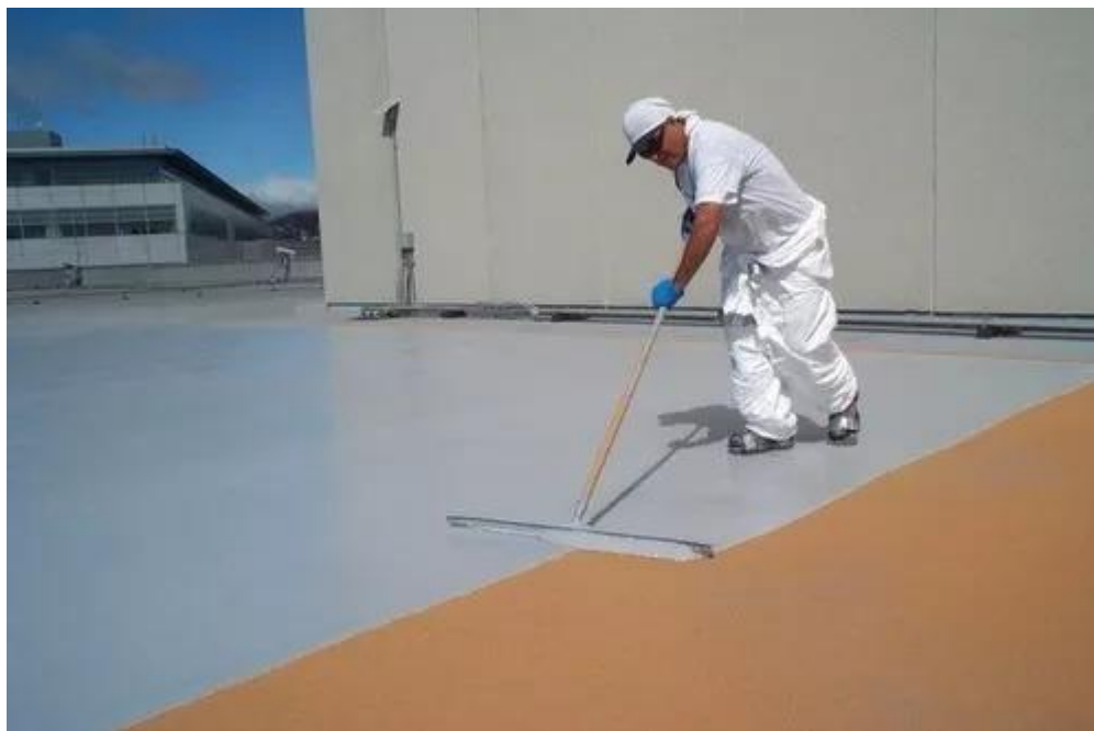
Figura 9 - Aplicação da manta líquida acrílica
