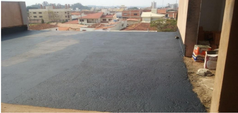
Figura 4 - Imprimação da superfície
