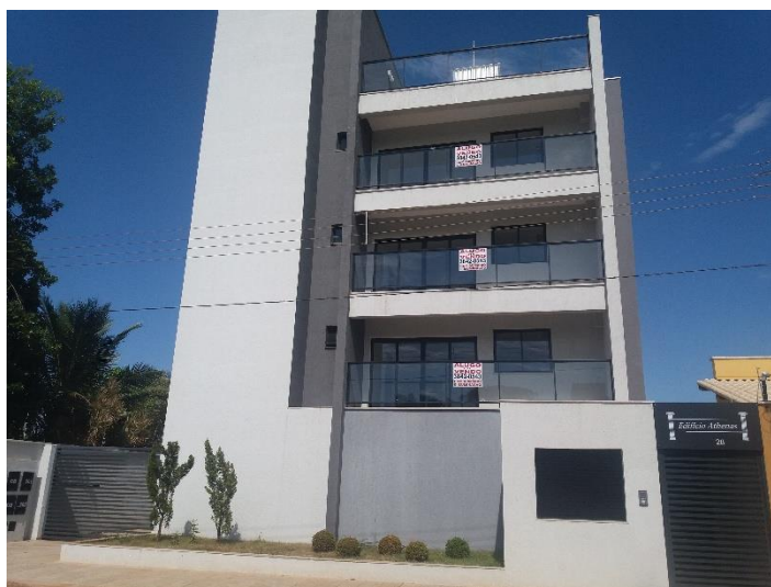
Figura 10 - Edifício residencial multifamiliar pronto
