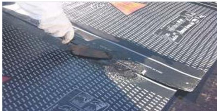
Figura 6 - Procedimento de biselamento
