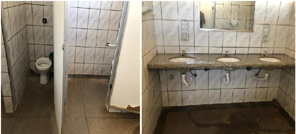
Figura 15 – Box e lavatório dos sanitários.
