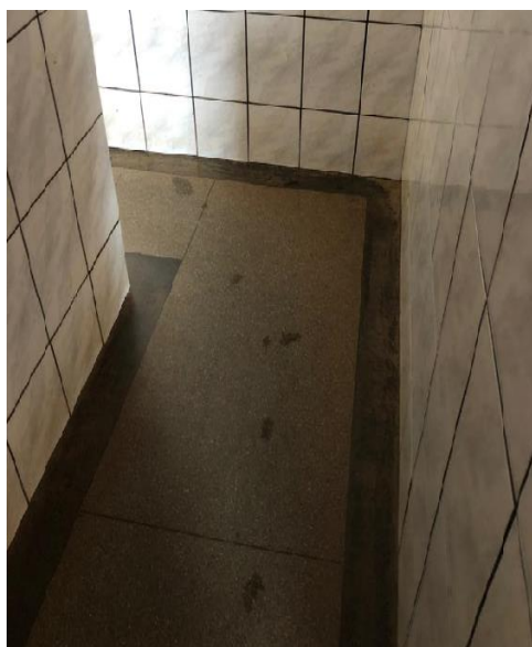
Figura 13 - Corredor dos sanitários
