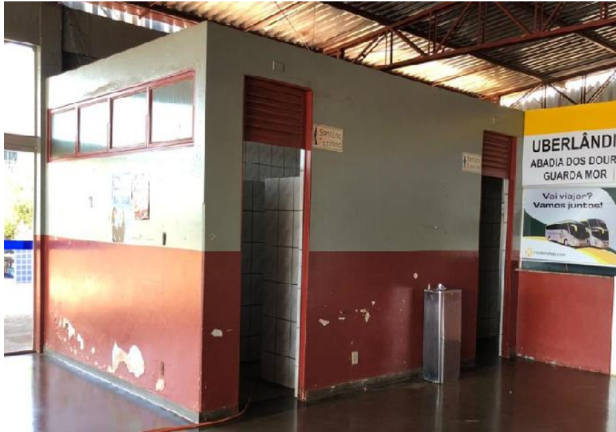
Figura 11 – Entrada dos sanitários feminino e masculino
