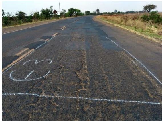
Figura 6 – Estação inventariada – E3
